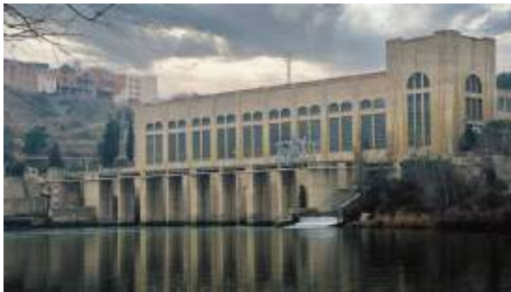
Central hidroelèctrica de Flix
